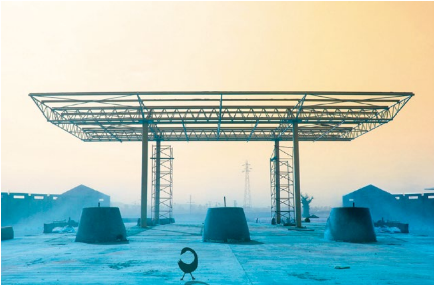
Baustelle der gebührenpflichtigen Autobahn zwischen Dakar und dem Aéroport International Blaise Diagne (AIBD), 2018. Fotografie aus der Afropixel #6-Broschüre, Kër Thioissane, Dakar (SN), 2018.
